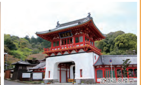
武雄温泉楼門
