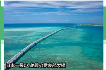
日本一長い、絶景の伊良部大橋
