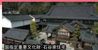
国指定重要文化財・石谷家住宅
